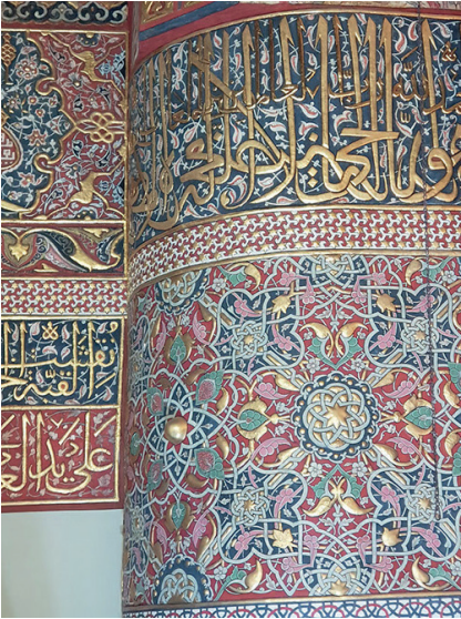
Fot.18b - Mevlana Türbesi Kubbe-i Hadrâ Filpayesi
