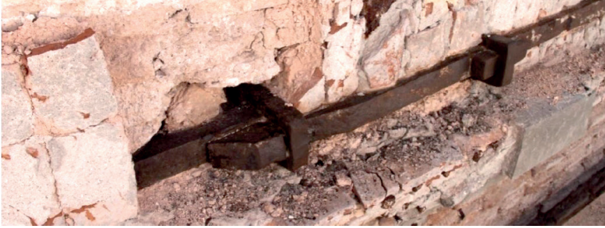
Resim 5.8. Esengül Yıldız Altunbaş, 2014, Kuzeybatı yönlü kasnakta tespit edilen gergi çemberi 49
